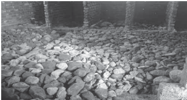
شکل ۴-۴ عملیات بنایی با سنگ
