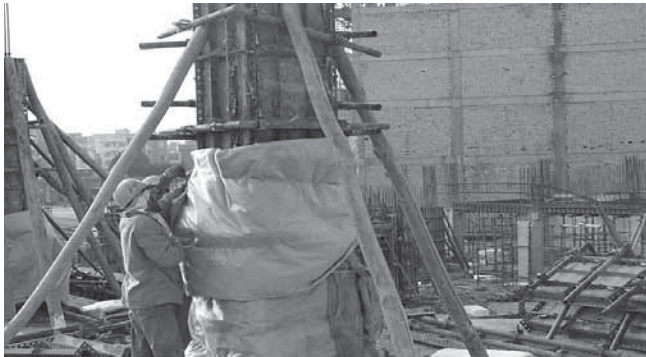
شکل ۴-۶ قالب بندی فلزی
