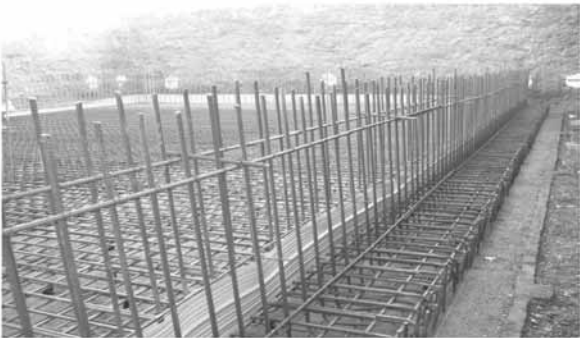
شکل ۷-۴ آرماتور گذاری پی و شناژ
