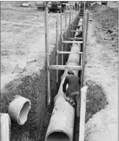
کارگران در حال اجرای پروژه آیفای بهبهان
